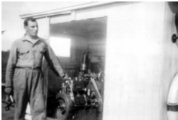
Bjursunds handdragna färja får 1933 en dieselmotor som driver på ett dragrep på färjans andra sida. Slitet med att dra färjan över strömmen blev ett minne blott.
