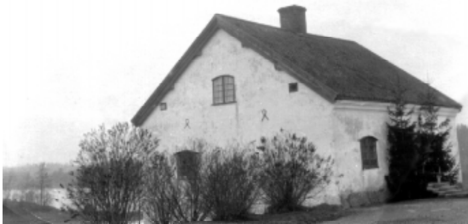
Corps de logis i Gursten från sent 1600-tal är ett av de äldsta husen i Lofta
